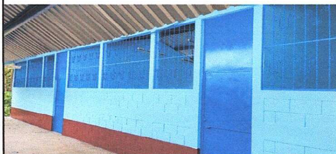
Foto 2: Culminación de la pintada del exterior del centro educativo del modulo 1.
