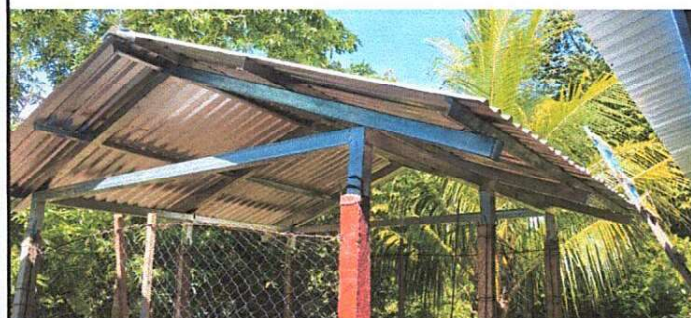
Foto 4: Finalización de entechado de la cocina educativa del modulo 3.
