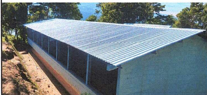
Foto1: Terminación de Entechado del centro educativo del modulo 1.
