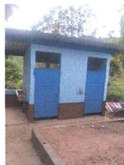
Foto 6: Terminación del mantenimiento de las puertas y pintura anticorrosiva de los baños del centro educativo del modulo 2
