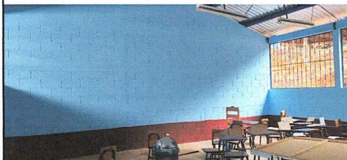
Foto 3: Terminación de la pintada del interior de las 3 aulas del centro educativo del modulo 1
