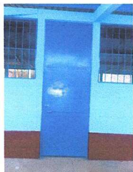
Foto 5: Finalización del mantenimiento de las puertas, chapas y pintura anticorrosiva del modulo 2.
